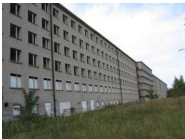
Bild 1: Fassade der KdF Anlage in Prora, die sich auf einer Länge von ca. 4,5 km entlang der Küste auf Rügen zieht.
